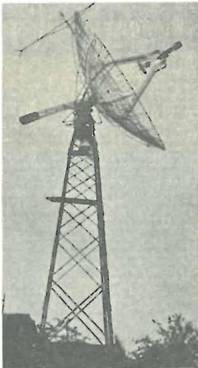
Fig. 3 - Lo splendido paraboloide del diametro di 8 metri posto su un traliccio di oltre 10 metri, rappresenta un'antenna veramente notevole. Ha due illuminatori, per le due gamme UHF, guadagno presumibile: 28 dB in 432 MHz e 37 dB in 1,3 GHz (N.d.R.).
